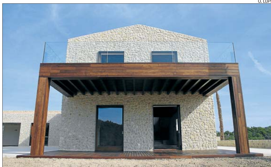
Doble crujía y dos aguas tradicionales con la piedra y la madera como protagonistas.
