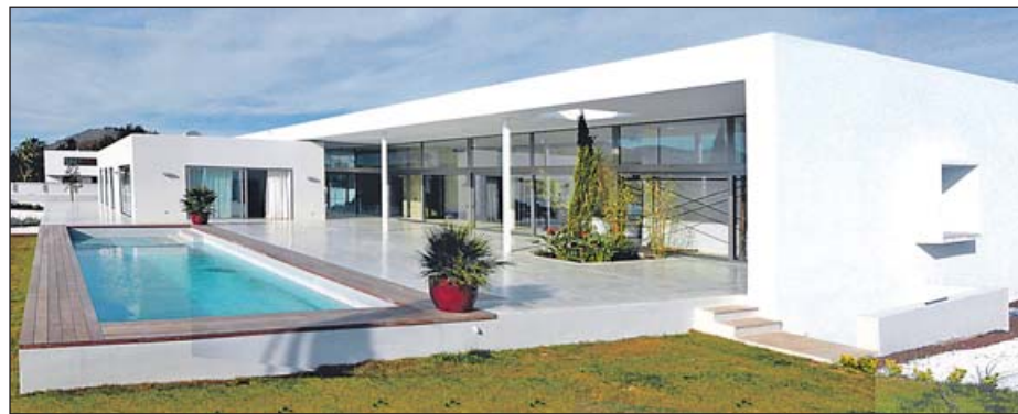
La casa se abre al interior de la parcela, generando intimidad y potenciando las vistas.
